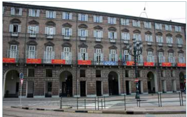
Die historische Fassade des Theaters, dahinter befindet sich der Neubau. Foto: Photo Ramella & Giannese für das Teatro Regio Torino
