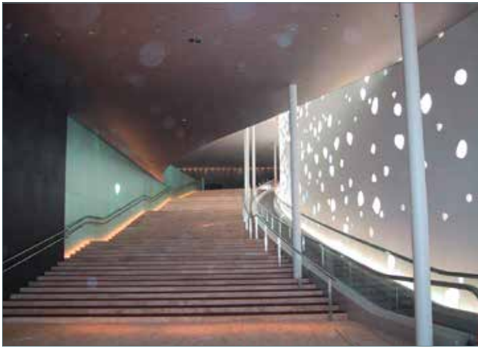
Schwung und Transparenz: Die sanft geschwungene Treppe folgt der Fassadenform. Licht fällt durch die Wände aus mit Glasfaser verstärktem Zement
