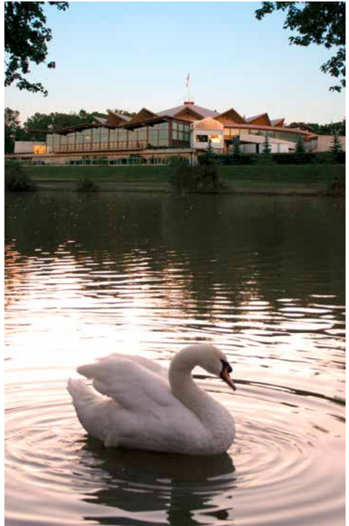
Zum Park hin offen: Bei der Renovierung 1997 wurde viel Glas in den Foyers eingesetzt. Die Zeltform wirkt einladend für das Festivalpublikum
