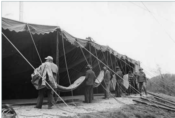
Erster Bau für das Stratford Festival 1952: Die Wände bestanden aus Beton, das Dach aus Segeltuch wurde manuell darüber gespannt
